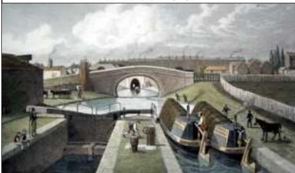
1827- Doble esclusa en la entrada al Túnel de Islington (878 m).
